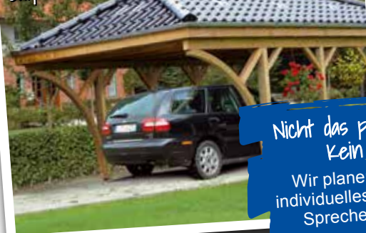
Carport mit Walmdach
